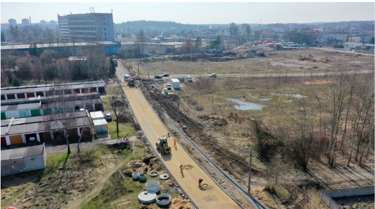
Zdjęcie 17 Budowa ul. Polnej
