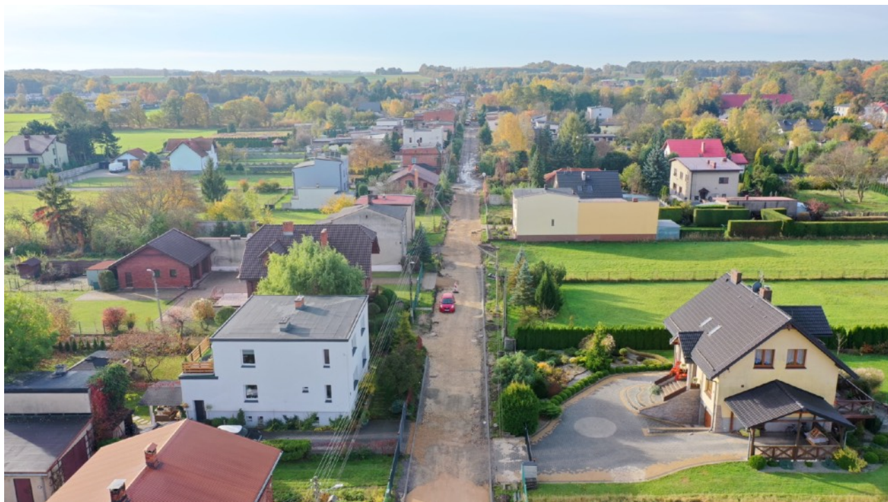
Zdjęcie 43. Budowa kanalizacji deszczowej w Rybnej
