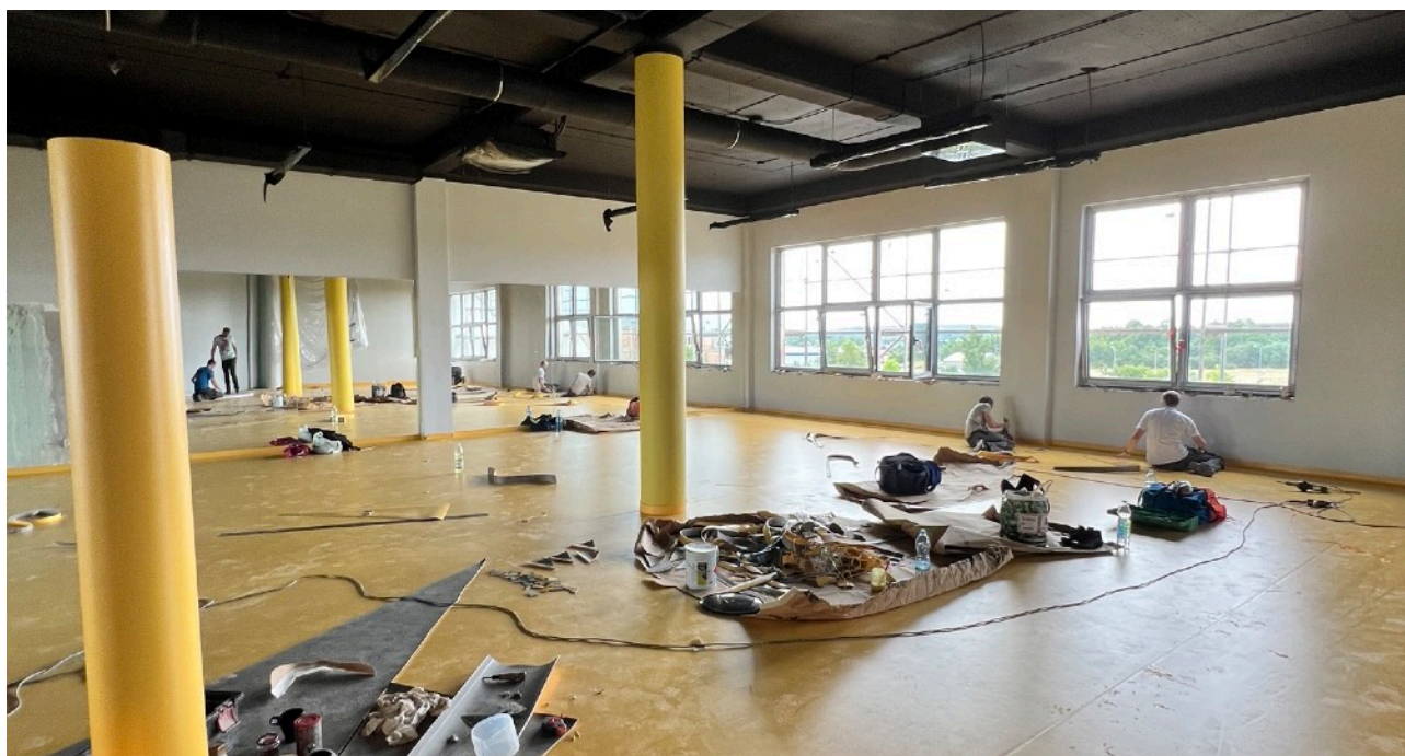
Zdjęcie 30. Remont Parku Wodnego
