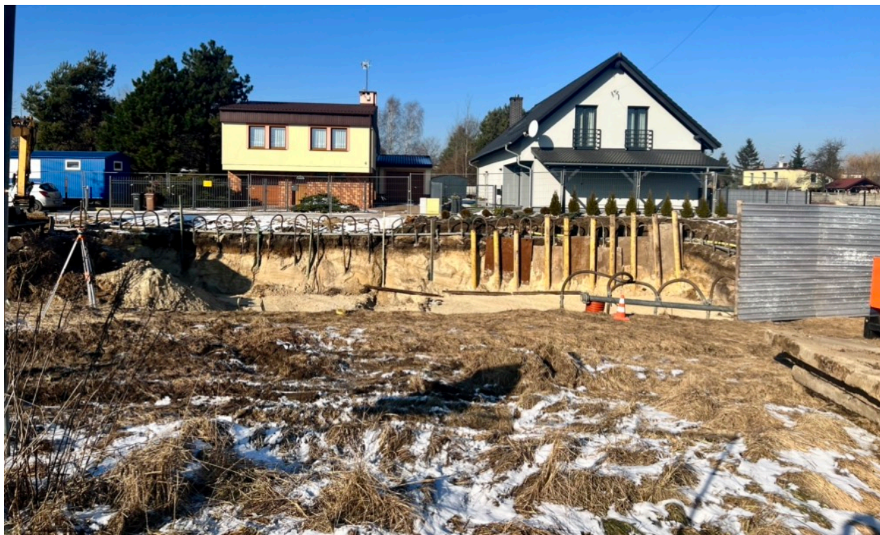
Zdjęcie 6. Budowa kanalizacji deszczowej w Rybnej
