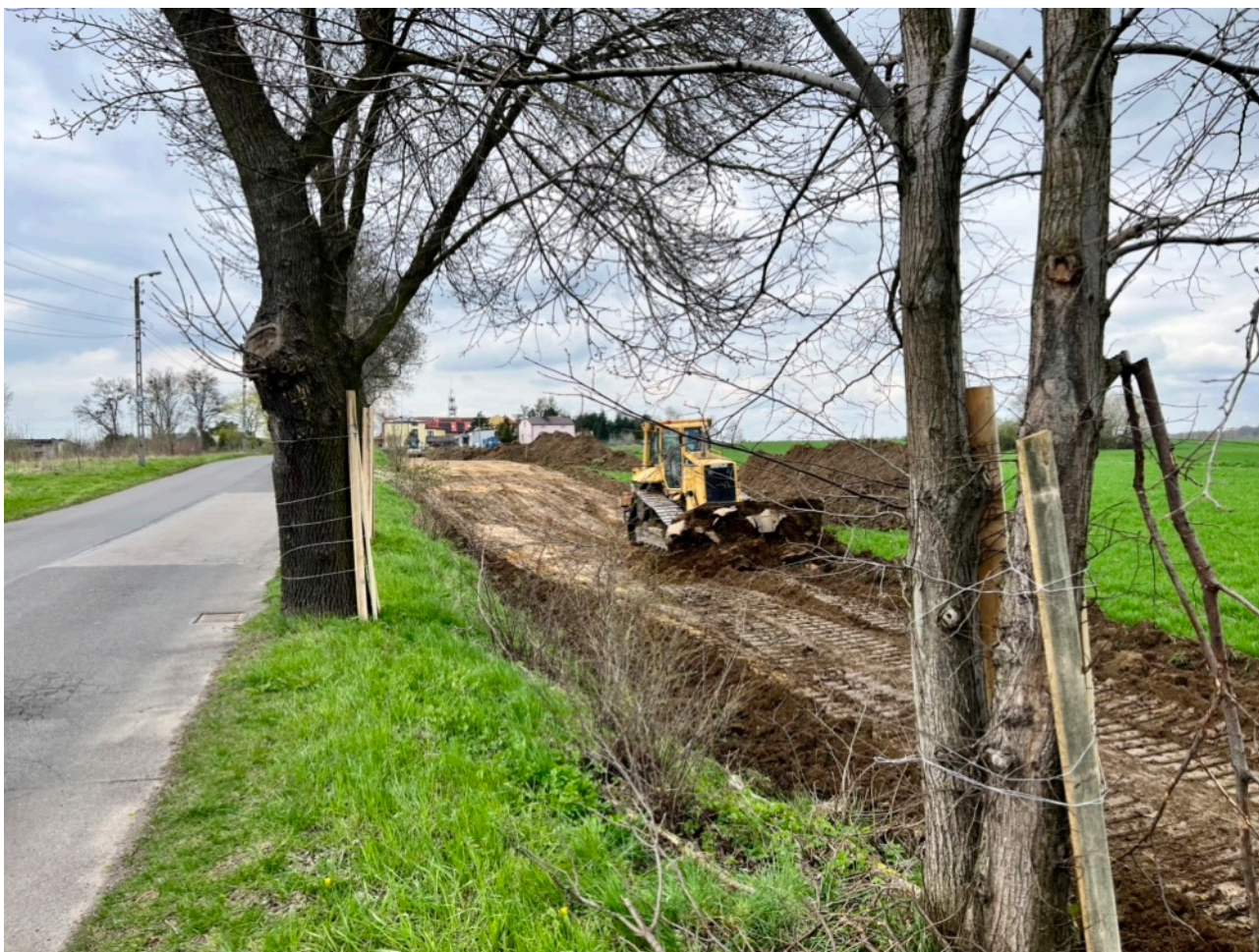
Zdjęcie 20. Budowa drogi rowerowej ul. Staffa
