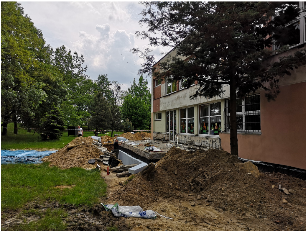
Zdjęcie 10. Termomodernizacja P20
