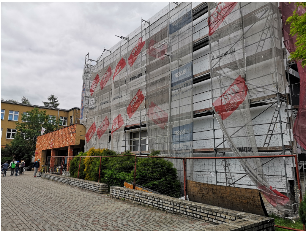
Zdjęcie 5. Termomodernizacja SP5
