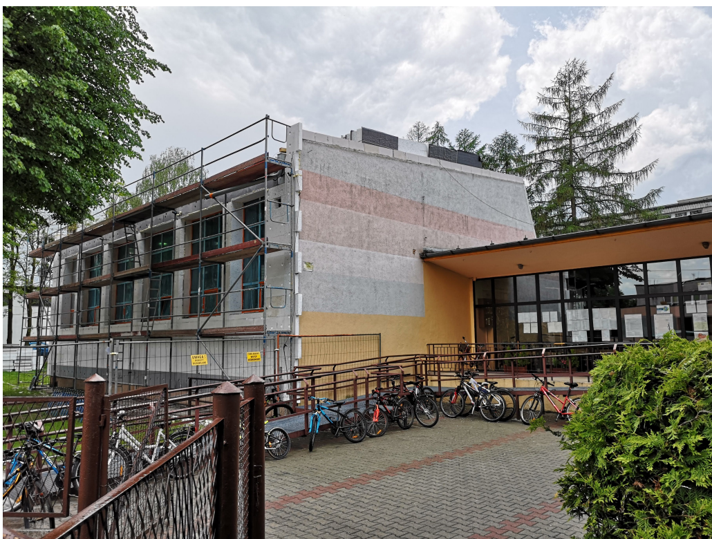
Zdjęcie 6. Termomodernizacja SP13
