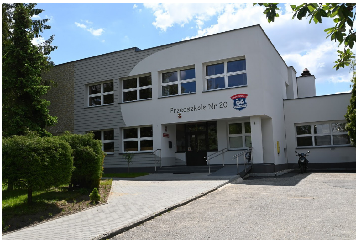
Zdjęcie 5 Termomodernizacja przedszkola Nr 20
