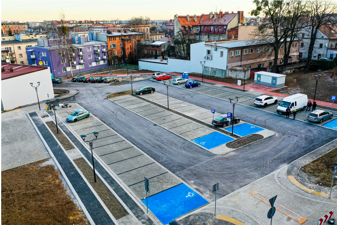
Zdjęcie 9 Budowa parkingu na miejscu po byłych zakładach Tarmilo
