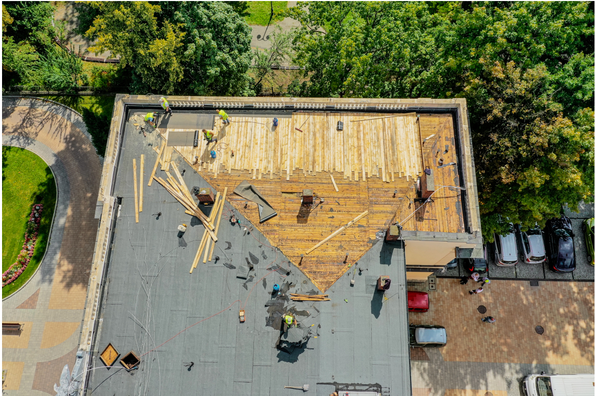
Zdjęcia 3 i 4 Remont Dachy na ul. Sienkiewicza
