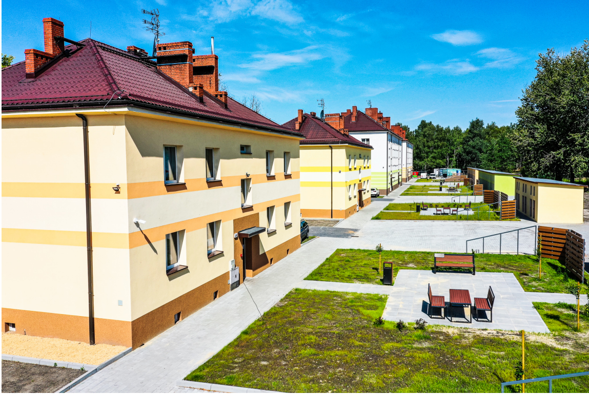
Zdjęcia 7 i 8 Rewitalizacją budynków przy ul. Grzybowej
